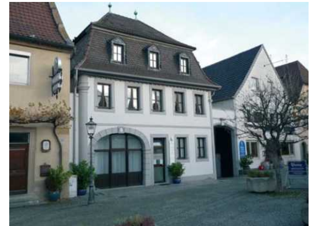
Rügshöfer Straße - Laden- und Wohnnutzung
