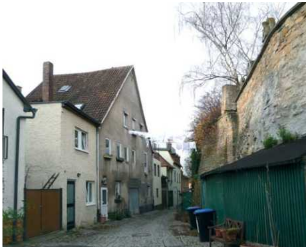
Wohnbebauung westliche Schuhstraße von Braugässchen aus gesehen
