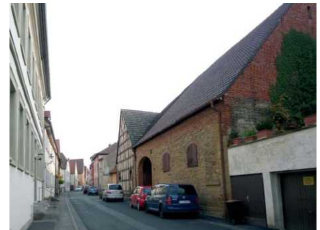
Nebengebäude in der Salzstraße - möglicher Umbau zur Parkscheune
