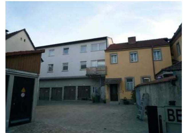
Hinterhofsituation in der westlichen Rügshöfer Straße
