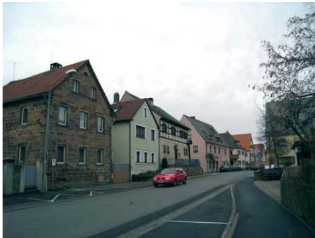
Grabenstraße - ungegliederter Straßenraum (G 7)
