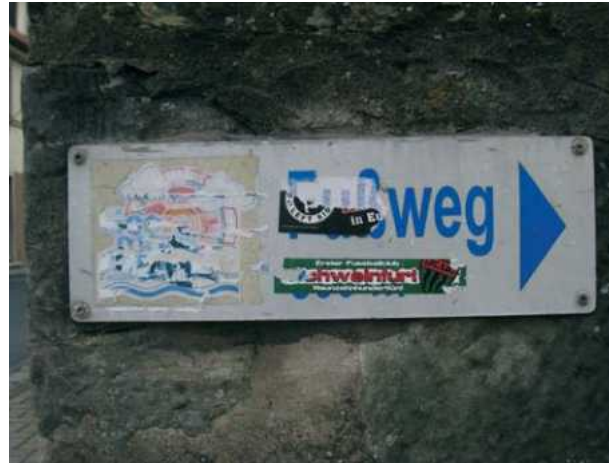
Mangelnder Pflegezustand im öffentlichen Raum
