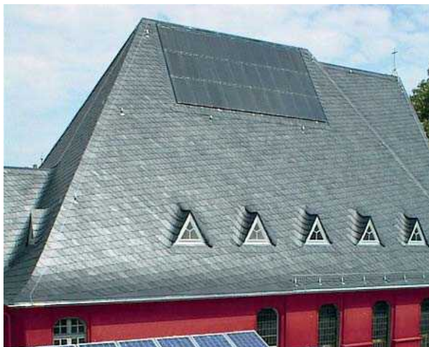
Beispiel für den altstadtverträglichen Einsatz von Photovoltaikmodulen (ÖKOL 2)
